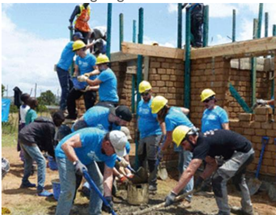
Mit der „menschlichen Betonpumpe“ transportieren die Freiwilligen in Windeseile den Beton in die Verschalung. Foto: Habitat for Humanity Deutschland
